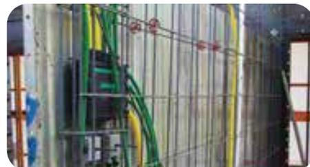
Montagem dos painéis da viga (Beam + SC).
