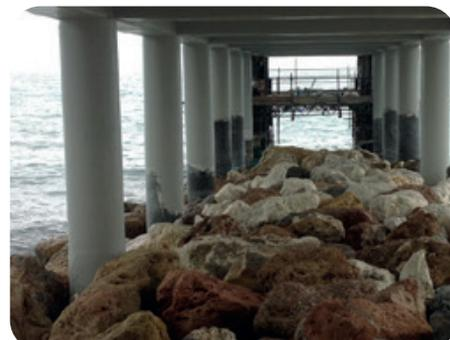
No caso de colunas danificadas, onde o ferro da armadura fica exposto devido à degradação do concreto, é necessário agir para reformar o estado adequado de cobertura. Com o Sistema de Pilares Circulares é possível realizar essa reforma nos casos em que o pilar já esteja pronto.
