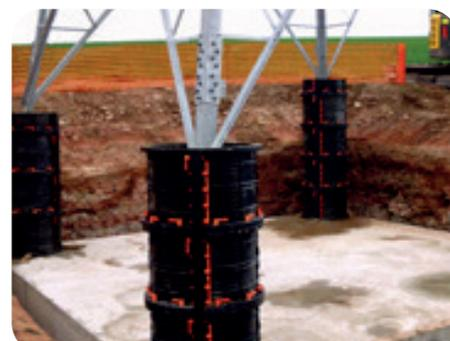
O Sistema de Pilares Circulares é indicado para a realização de novas bases para postes. A leveza faz dessa fôrma um elemento fácil de transportar manualmente e simples de montar. A divisão em módulos e a instalação lateral através dos puxadores as tornam essenciais, sobretudo em casos onde é impossível colocar elementos do alto.
