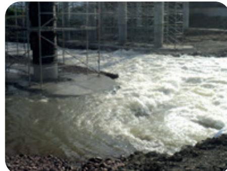
O Sistema de Fôrmas para Pilares Circulares é particularmente indicado para realizar colunas quando a obra é realizada submersa em água, condição que gera um trabalho difícil e delicado. Nesse caso, é a única solução segura, já que é construído em ABS, material que ao contrário do aço, não se deteriora pela ação dos agentes atmosféricos. Graças a sua leveza e praticidade, o trabalho dos operadores é muito ágil mesmo nas condições difíceis descritas aqui.
