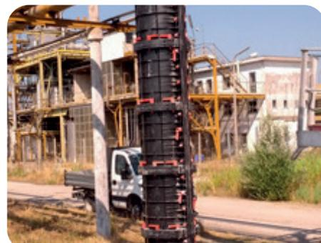
Frequentemente é necessário ajustar as medidas dos pilares, para prevenir danos ligados ao risco sísmico. As fôrmas modulares do Sistema de Pilares Circulares podem ser movidas manualmente o que permite a sua utilização em lugares onde as fôrmas de aço, pesadas e feitas de uma única peça, não podem ser colocadas. Os puxadores permitem a instalação lateral evitando ter que colocá-las do alto.
